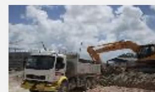
ゼネコンが建設現場で導入 建機遠隔制御
